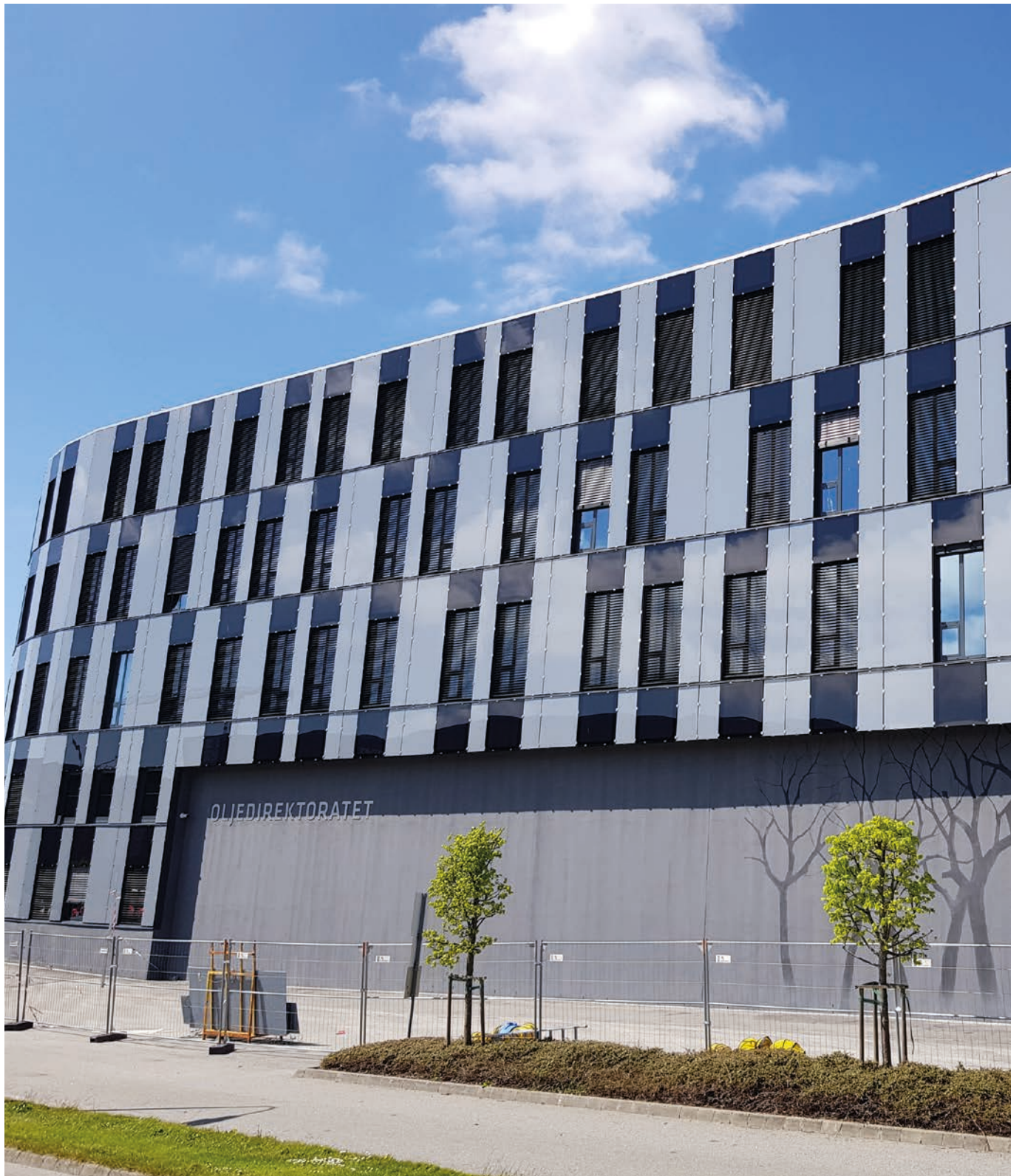
Bygningsintegrert solcelleanlegg i Oljedirektoratets fasade - Bilde: FUSen
